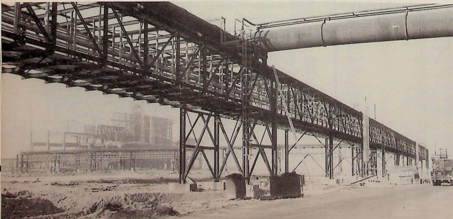
Chantier de la Solmer à Fos-sur-Mer.
